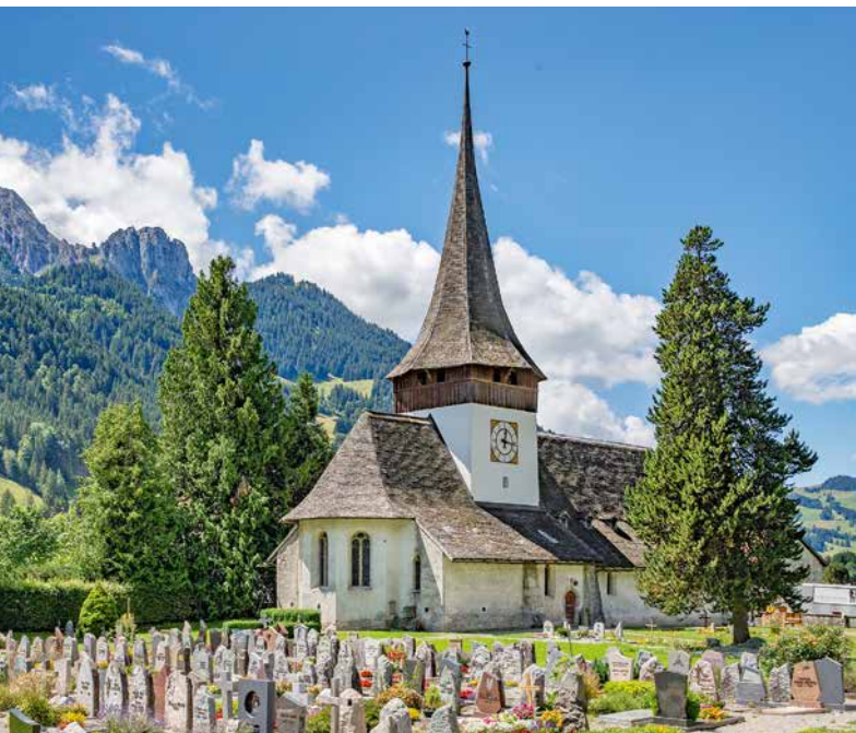
La restauration de l'église de Rougemont entre 1919 et 1926 montre à quel point les compétences ont évolué en moins d'un siècle.
