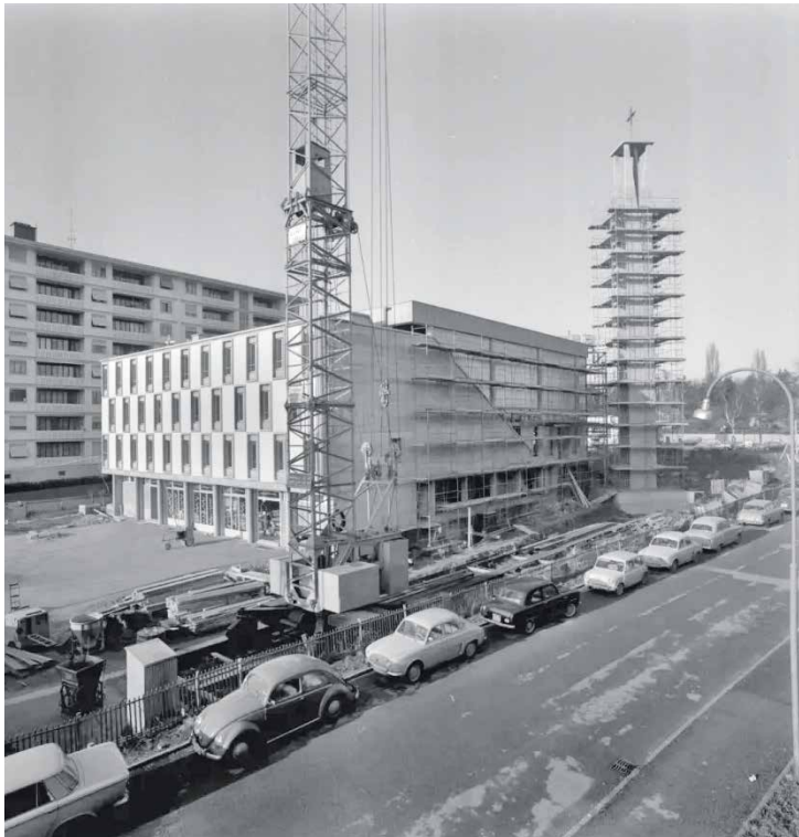
Saint-Pie X lors de sa construction en 1962.
